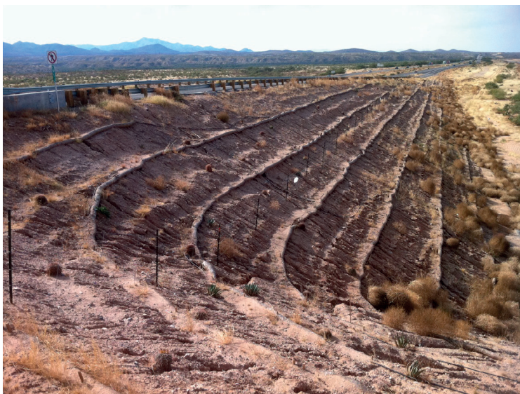
Figura 2 | Típico ejemplo de un inadecuado control de la erosión y los sedimentos en zonas áridas de los Estados Unidos, en donde por norma se aplican técnicas que son efectivas solamente en climas más húmedos (García-Chevesich y Etra, 2012).
